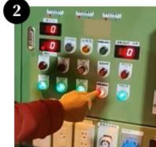
2. 送入電源並測試跳脫電流
