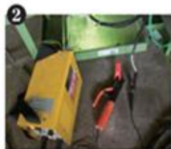
2. 測試線接線完成 *防電擊測試, 外殼不用接地
